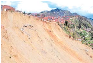
EL PELIGRO DE DESLIZAMIENTO ES LATENTE EN SAN JUAN DE PAMPAHASI BAJO CENTRAL.
