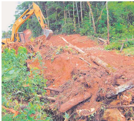
LA EMPRESA CONSTRUCTORA OAS NO PARTICIPARÁ DE LA CONSTRUCCIÓN DEL TRAMO II DE LA CARRETERA VILLA TUNARI-SAN IGNACIO DE MOXOS QUE ESTABA PROYECTADO ATRAVESAR LA RESERVA NATURAL.
