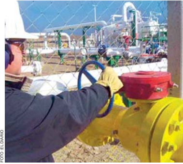
TRABAJOS DE MANTENIMIENTO INFLUYERON EN LA REDUCCIÓN DE ENVÍO DE GAS NATURAL A MERCADOS DE BRASIL Y ARGENTINA.
