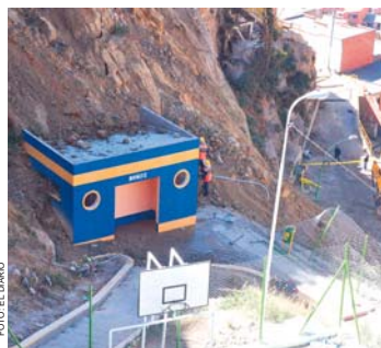
EL BLOQUE DE TIERRA QUE CEDIÓ AFECTÓ A LA ESTRUCTURA DE UN CAMPO DEPORTIVO DE LA ZONA ALTO TACAGUA.
