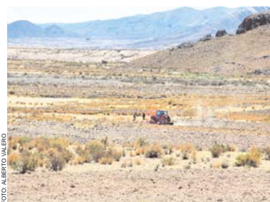
CON LA AYUDA DE UN TRACTOR Y LA ASISTENCIA DE TÉCNICOS, EN EL ALTIPLANO SE TRABAJA EN LA PERFORACIÓN DE POZOS.
