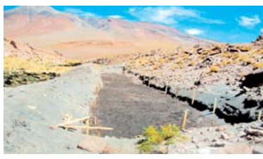
LA IMAGEN MUESTRA EL TERRENO TRAZADO Y LOS ÁNGULOS DELIMITADOS POR UNOS POSTES. ESTÁ SERÁ UNA DE LAS SEIS PISCINAS.
