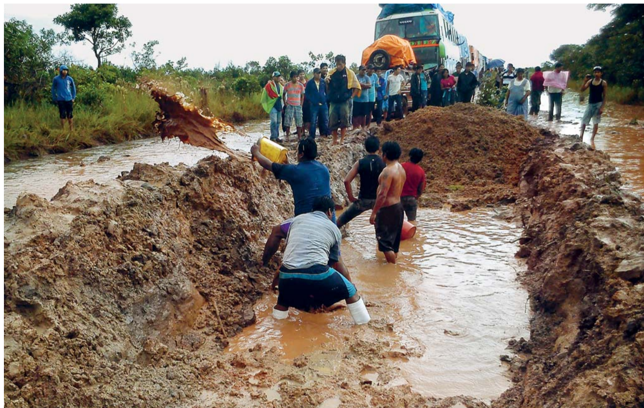
LAS FUERTES LLUVIAS ANEGARON LOS TRAMOS CAMINEROS DE ACCESO Y SALIDA A LAS POBLACIONES DEL NORTE PACEÑO. CASI TODAS LAS VÍAS ESTÁN INHABILITADAS POR DESLIZAMIENTOS Y HUNDIMIENTO DE CARRETERAS.
