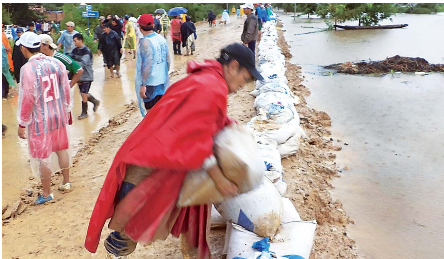
LA CIUDAD DE TRINIDAD PROTEGIDA DESDE LOS SECTORES OESTE, SUR Y ESTE, POR MONTÍCULOS DE TIERRA, QUE EN ANTERIORES DÍAS PRESENTARON ALGUNAS FILTRACIONES QUE FUERON ATENDIDAS POR LOS VECINOS.
