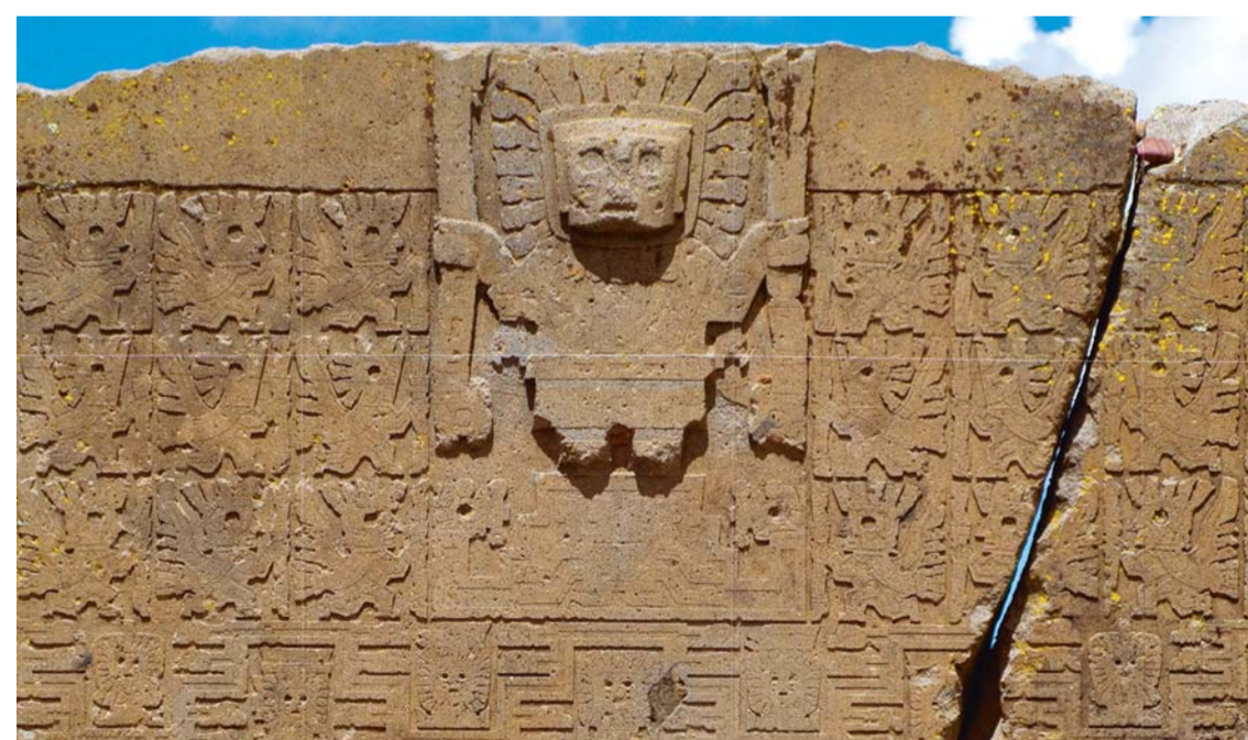
PUERTA DEL SOL, PIEZA MONOLÍTICA DE INCALCULABLE VALOR, MUESTRA SERIO DETERIORO POR LA HUMEDAD Y LA FALTA DE CONSERVACIÓN.
