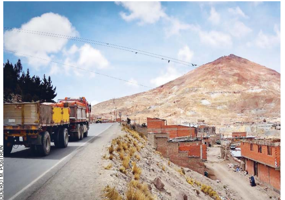
EL GOBIERNO APROBÓ LA EJECUCIÓN DE UN PROYECTO QUE BENEFICIARÁ POR LO MENOS A UN 70% DE COOPERATIVISTAS ANTE LAS AVERÍAS REGISTRADAS EN EL CERRO RICO DE POTOSÍ.
