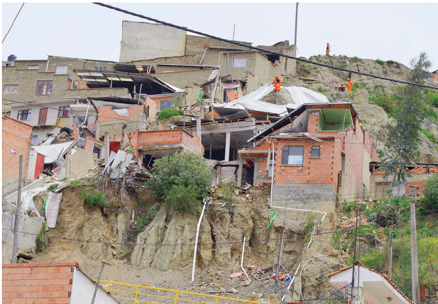
VECINOS DE CASI UNA DECENA DE VIVIENDAS DE LA ZONA SAN ALBERTO SINTIERON LOS EFECTOS DE LA INTENSA LLUVIA CAÍDA EN LAS ÚLTIMAS HORAS EN LA CIUDAD DE LA PAZ.
