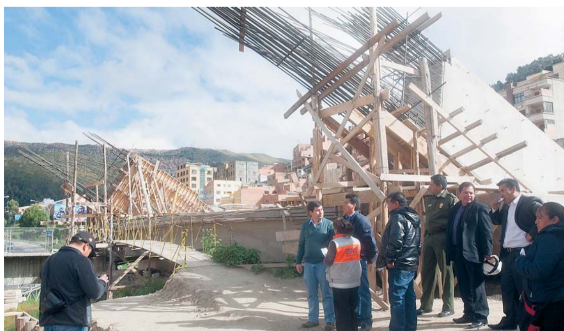
EL PUENTE FERROBENI TENDRÁ LA CAPACIDAD PARA SOPORTAR EL PESO DE CAMIONES CON CARGA PESADA.
