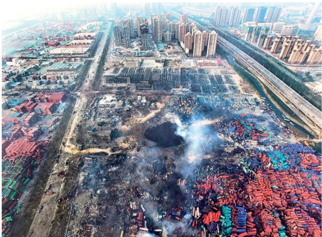
LA TRAGEDIA CONTINÚA EN EL PUERTO DE TIANJIN (CHINA) A CAUSA DE LA CONTINUIDAD DEL INCENDIO Y LA SUCESIÓN DE NUEVAS EXPLOSIONES.
