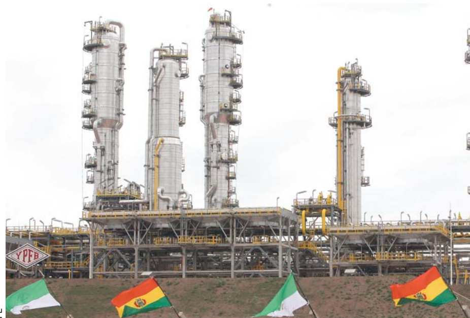
VISTA DE LA PLANTA BOLIVIANA DE HIDROCARBUROS CARLOS VILLEGAS.
