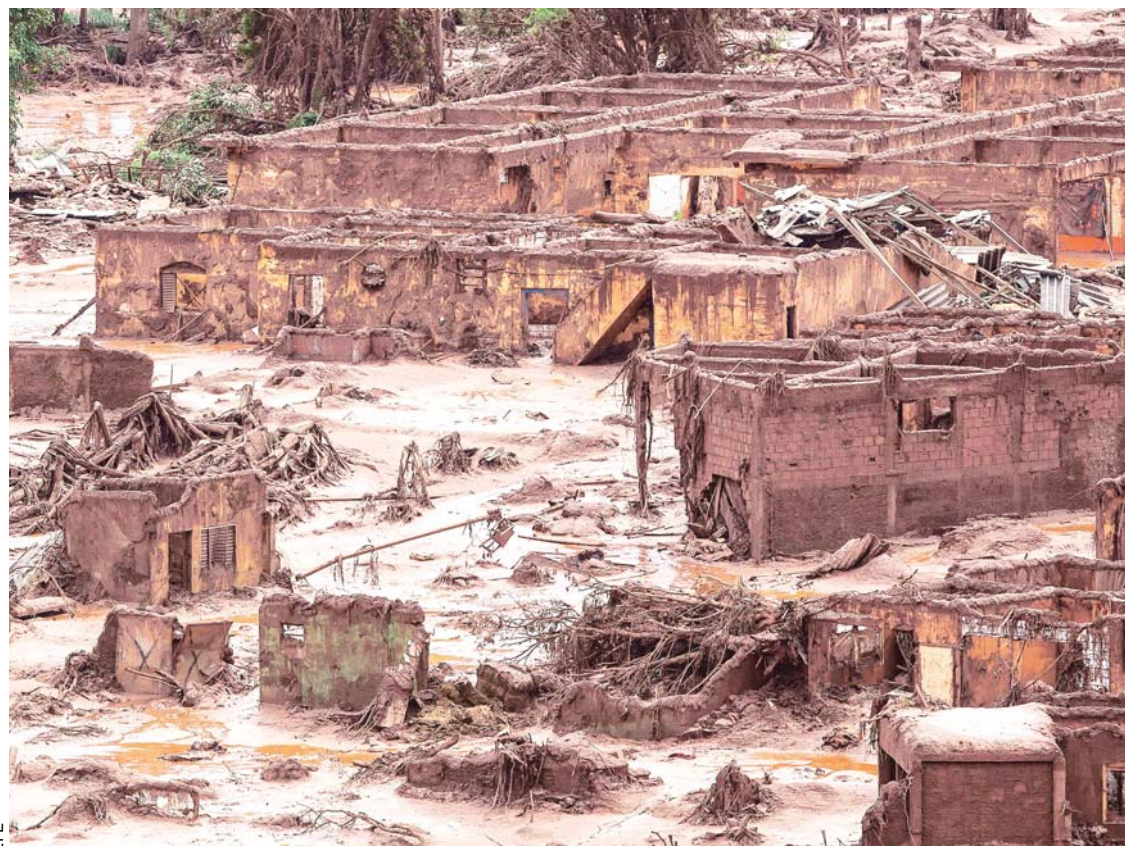
PANORAMA DESESPERANTE QUE SE OBSERVA AL SURESTE DEL BRASIL, DESPUÉS DE LA RUPTURA DE DOS DIQUES DE UN COMPLEJO MINERO.
