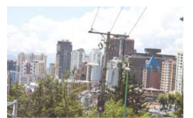
CABLES A LA INTEMPERIE EN EL CENTRO DE LA PAZ.
