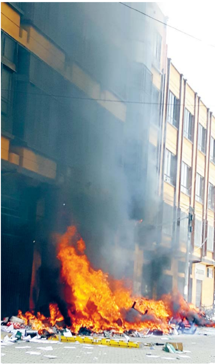
EL EDIFICIO DE LA ALCALDÍA MUNICIPAL DE LA CIUDAD DE EL ALTO FUE INCENDIADO Y SUFRIÓ DAÑOS CONSIDERABLES.
