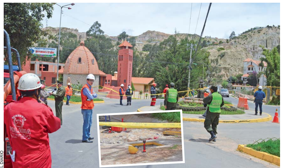
PERSONAL DE LA UNIDAD DE BOMBEROS ACUDIÓ AL LUGAR PARA TOMAR CONTROL DE LA FUGA DE GAS DOMICILIARIO.
