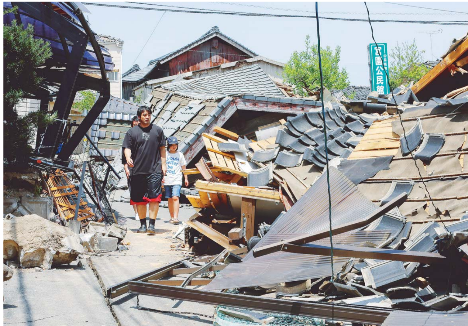
RESIDENTES CAMINAN ENTRE LOS ESCOMBROS DE UN EDIFICIO, EN MASHIKI, LUEGO DE UN POTENTE TERREMOTO REGISTRADO EN JAPÓN.
