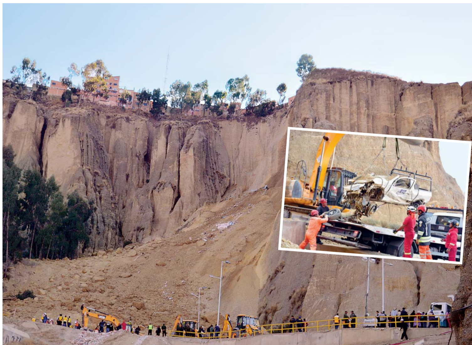
EFFECTIVOS DEL ORDEN, RESCATISTAS EDILES Y BOMBEROS SE TRASLADARON A LA ZONA NIÑO KOLLO DE LA CIUDAD DE LA PAZ PARA AUXILIAR A LAS PERSONAS AFECTADAS POR EL DESLIZAMIENTO DE TIERRA. LOS HABITANTES DE LAS VIVIENDAS ALEDAÑAS FUERON EVACUADOS DEL LUGAR A FIN DE PRECAUTELAR SU SEGURIDAD.
