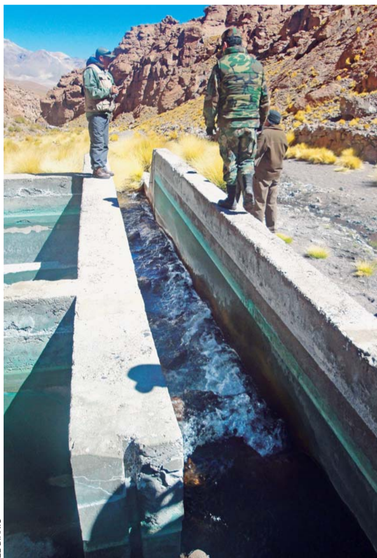
EL RECURSO HÍDRICO FUE DESVIADO A TRAVÉS DE CANALIZACIONES HACIA CHILE.
