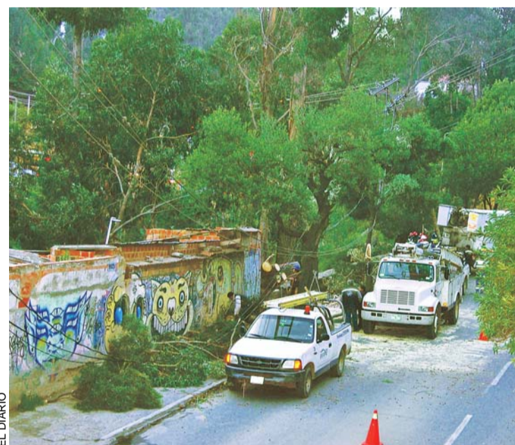
FUNCIONARIOS DE LA ALCALDÍA Y DE TÉCNICOS DE LA EMPRESA DELAPAZ SE MOVILIZARON PARA SOLUCIONAR EL IMPREVISTO CON EL POSTE DE ENERGÍA.
