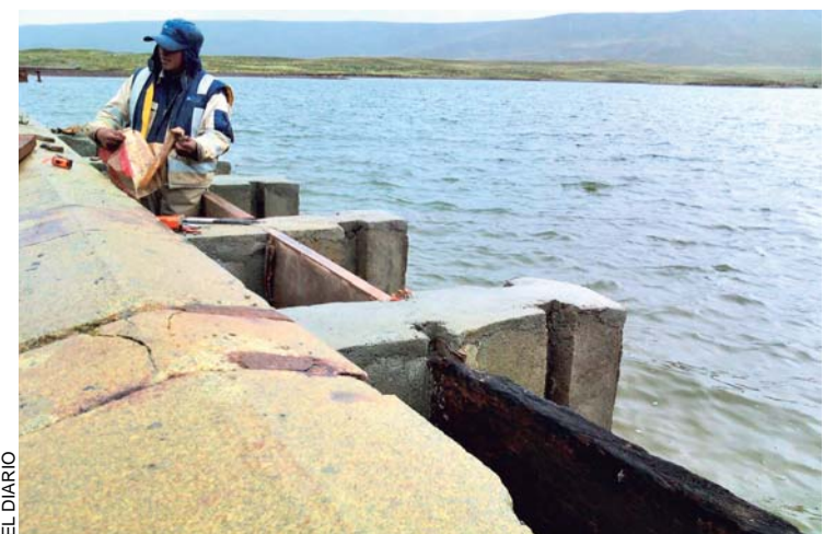
LA REPRESA DE MILLUNI CONTINÚA ACUMULANDO AGUA PARA ALCANZAR EL NIVEL PROYECTADO.
