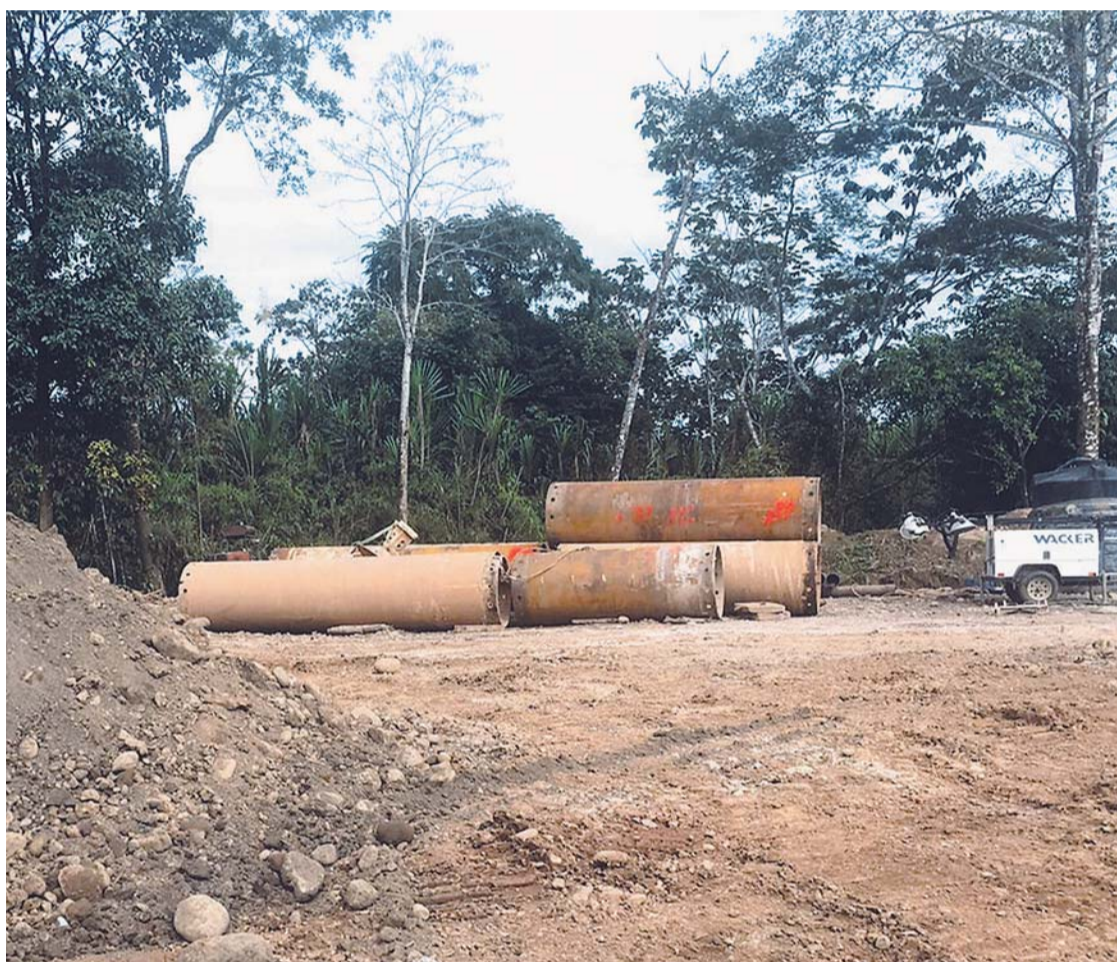
EN EL PARQUE NACIONAL ISIBORO-SECURE YA SE HABRÍAN INICIADO LAS OBRAS DE CONSTRUCCIÓN DE LA CARRETERA QUE ATRAVESARÁ LA RESERVA ECOLÓGICA.
