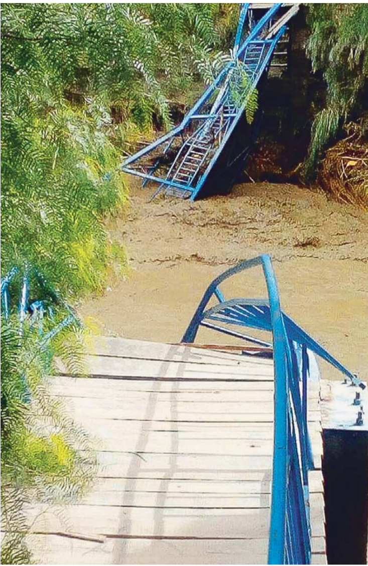
LA FUERZA DE LAS AGUAS SE LLEVÓ UN PUENTE EN EL ÁREA RURAL DE POTOSÍ.
