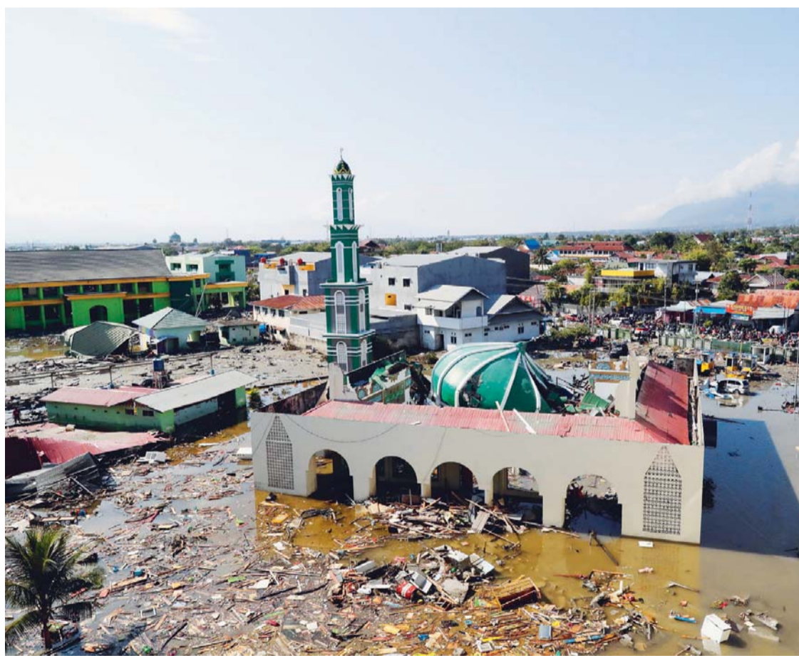
VISTA GENERAL DE UNA MEZQUITA DEVASTADA POR UN TSUNAMI EN LA PLAYA DE TALISE, PALU, SULAWESI CENTRAL, INDONESIA, 30 DE SEPTIEMBRE DE 2018.
