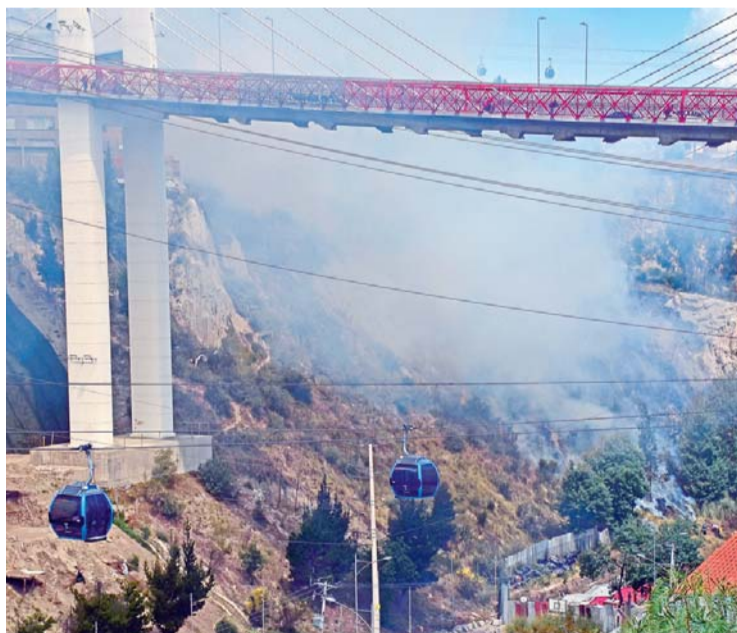
INCENDIO EN LA AVENIDA DEL POETA.
