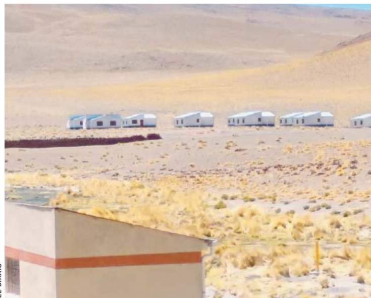
VIVIENDAS CONSTRUIDAS EN CERCANÍA DE LOS BOFEDALES DE AGUA EN EL SILALA.
