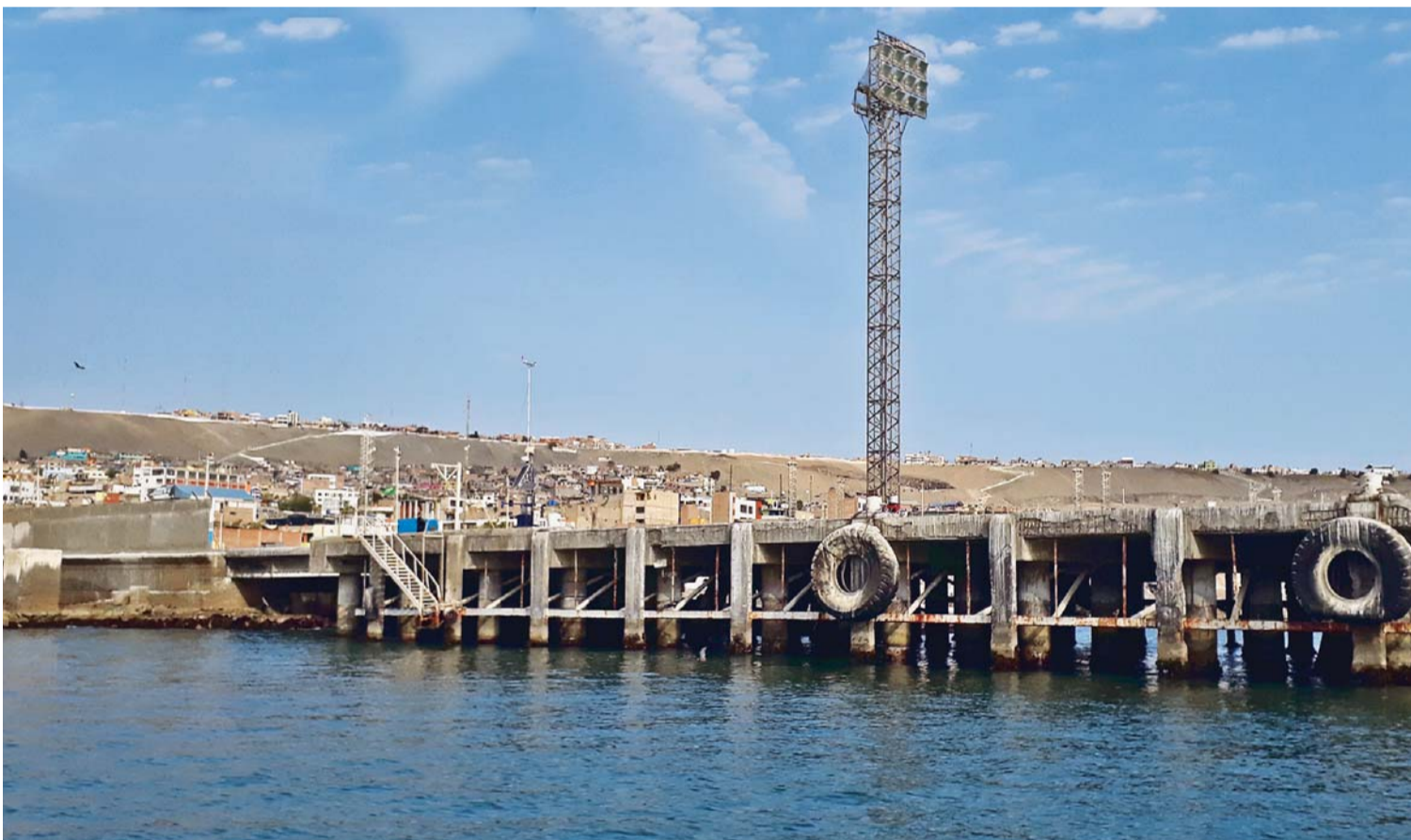
LA EMPRESA NACIONAL DE PUERTOS (ENAPU) ES EL ÚNICO PUERTO DEL ESTADO PERUANO SITUADO EN LA COSTA DE ILO POR DONDE PASA CARGA BOLIVIANA.
