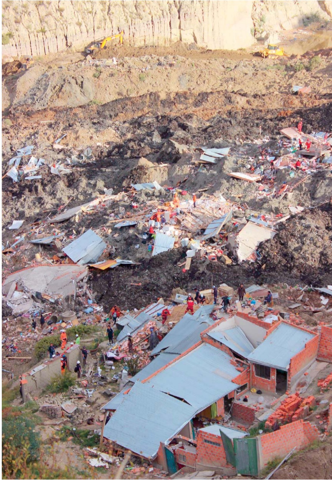
EQUIPOS DE EMERGENCIAS TRABAJAN ESTE MIÉRCOLES EN EL LUGAR DONDE SE HA PRODUCIDO UN DESLIZAMIENTO DEL TERRENO EN LA PAZ.
