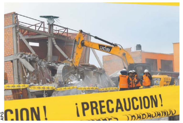
LA ZONA DEL DESLIZAMIENTO ES SOMETIDA A TRABAJOS DE ESTABILIZACIÓN.
