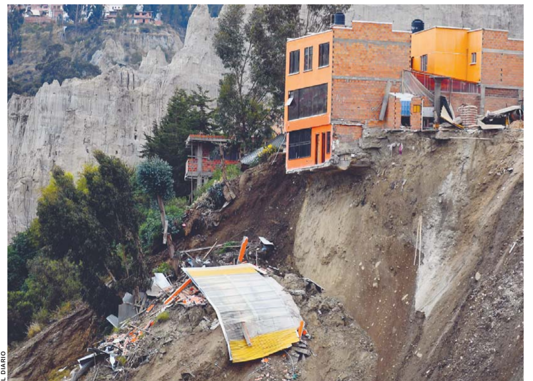
DESlizamiento en la zona de Bajo San Jorge- Kantutani en La Paz.
