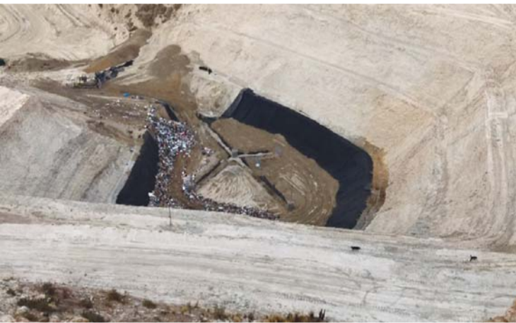
CELDA 1 DEL RELLENO SANITARIO TRANSITORIO DE SAK'A CHURU.
