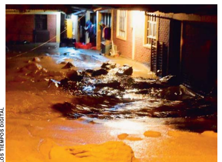
TIQUIPAYA INUNDADA POR UNA DENSA MAZAMORRA.
